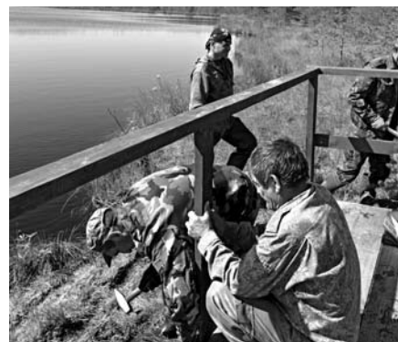
Строительство смотровой площадки на озере Кошеер
